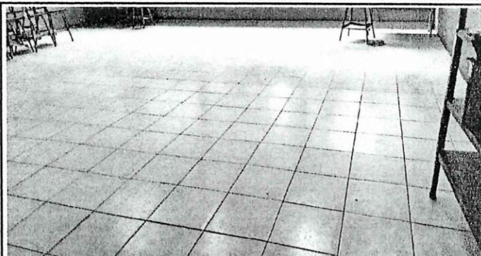
Foto 2: Se observa ya instalado el piso cerámico de 6 aulas y dirección.
